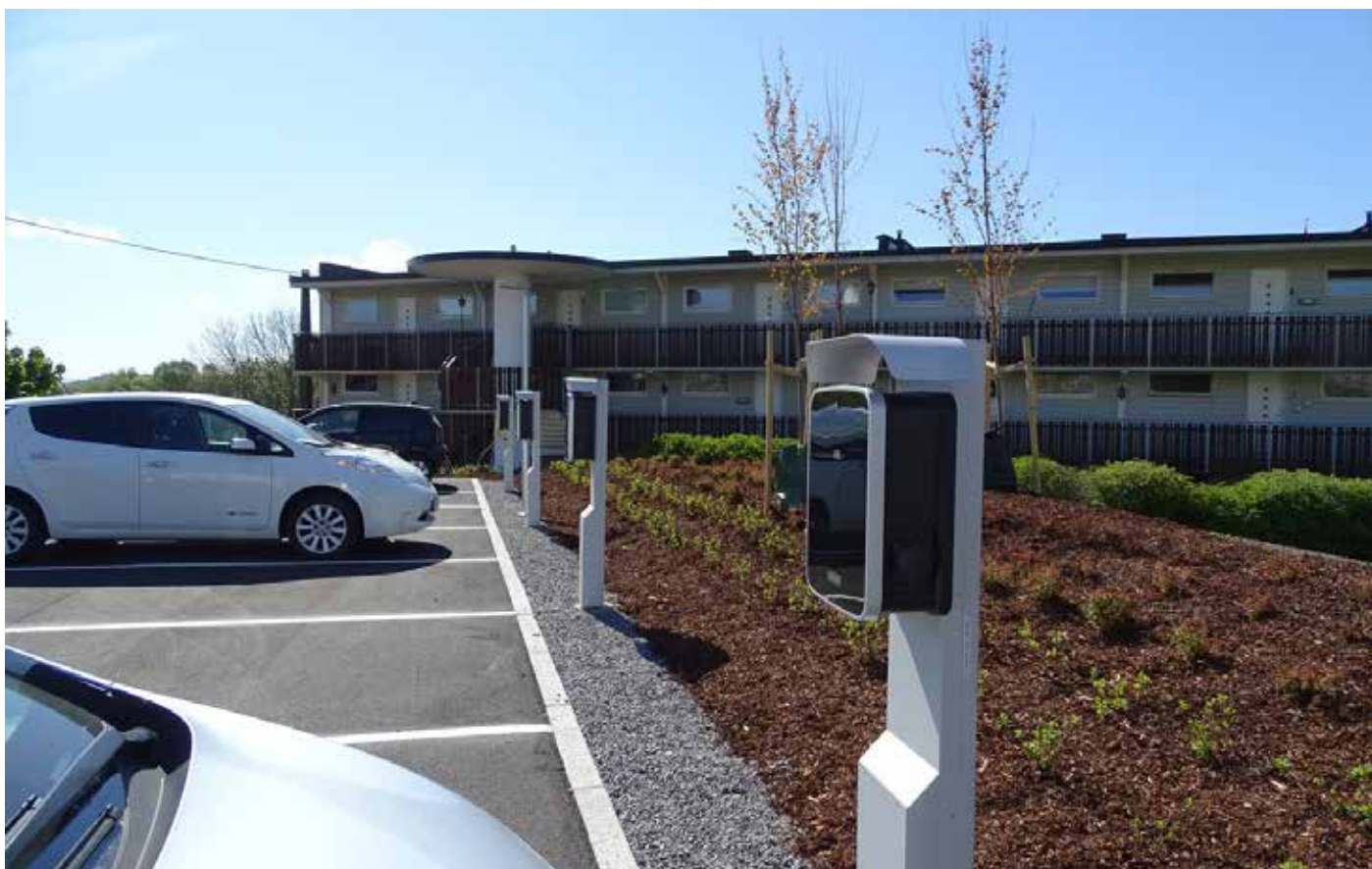
Parkeringsplats för BRF-boende
