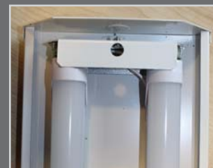
Plåt som ger extra stölskydd av LED rören.
